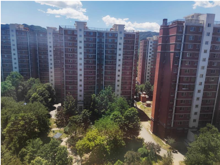
图 14-4 温泉凯盛家园项目实景图
