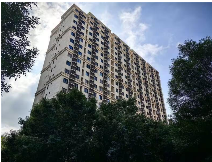
图 14-3 盛悦家园项目实景图
