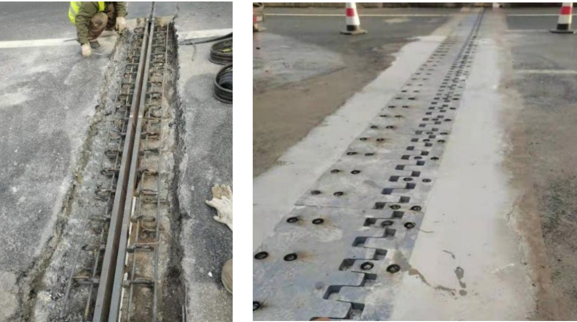
使用高聚物修补桥梁伸缩缝
